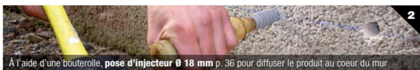
À l'aide d'une bouterolle, pose d'injecteur  $\varnothing$  18 mm p. 36 pour diffuser le produit au coeur du mur
