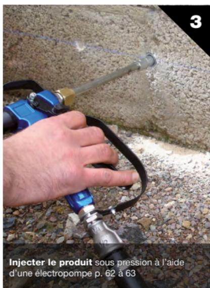
Injecter le produit sous pression à l'aide d'une électropompe p. 62 à 63
