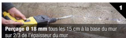
Perçage  $\varnothing$  18 mm tous les 15 cm à la base du mur sur 2/3 de l'épaisseur du mur
